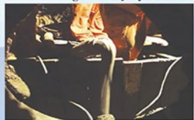
泵送浇注 Pumping pouring
